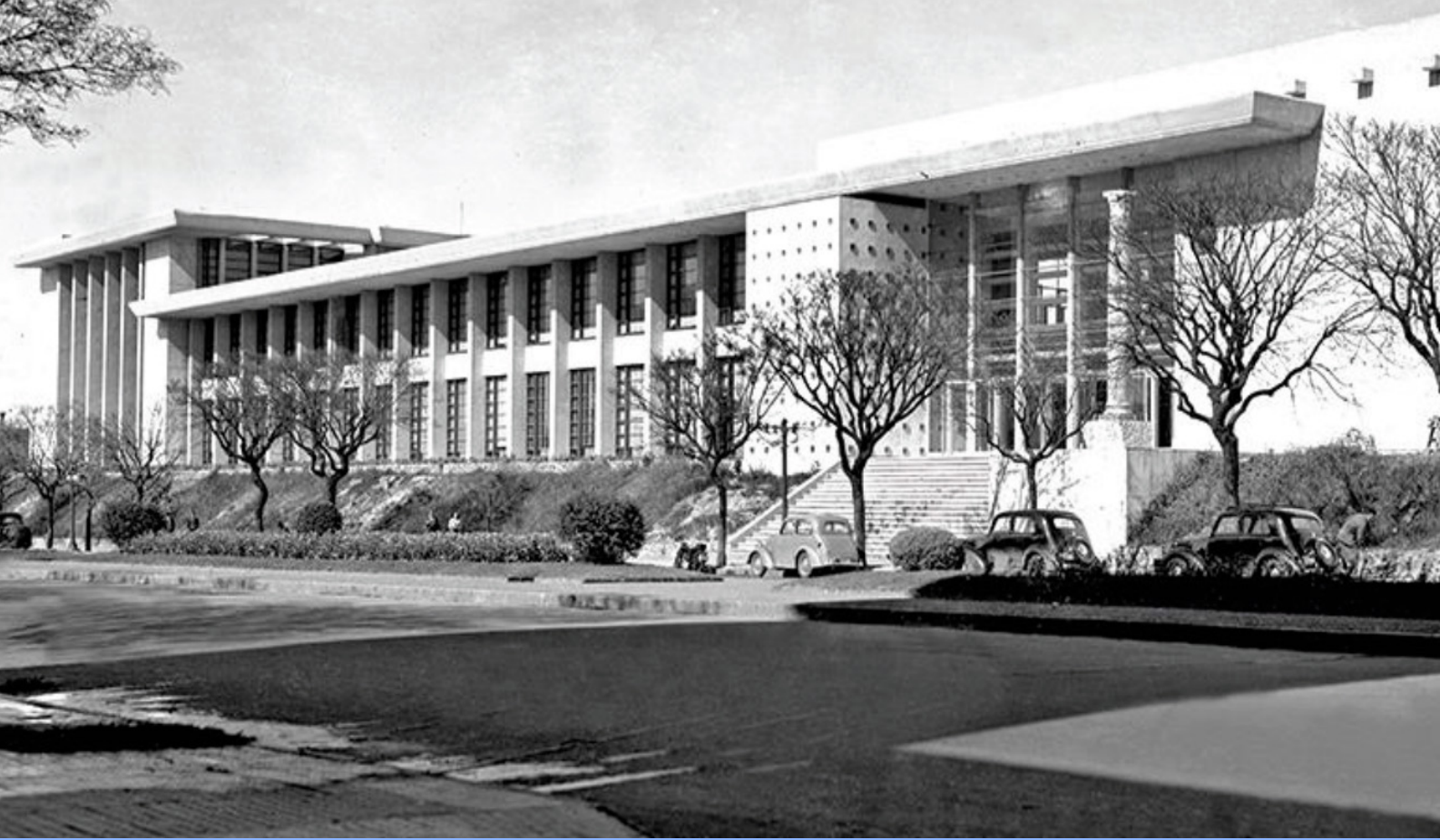
Imagen histórica del edificio central de la FADU/Udelar.
