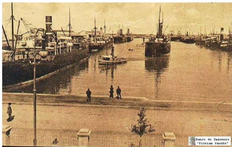
Figura 5: Dique 1 del puerto de ultramar. Hacia 1912. Fuente: Banco de imágenes “Florián Paucke”
