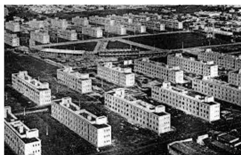
Construção do Barrio Manuel Dorrego, em Buenos Aires, de 1949, que fazia parte do Plan Eva Perón de Vivienda, financiado pelo BHN.
